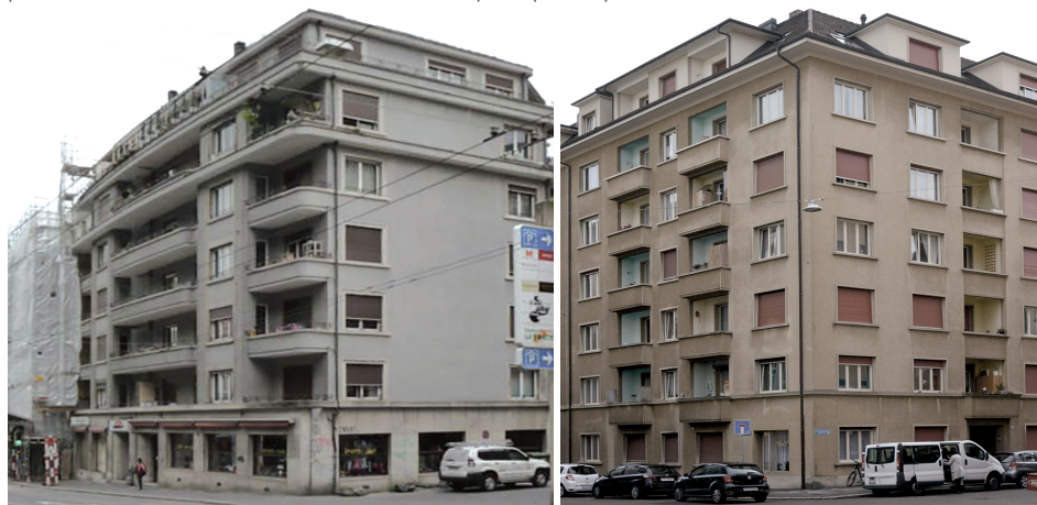
Fig. 22 et 23 de gauche à droite. Bâtiment construit en 1939 à Lausanne (étude de cas 03), bâtiment construit en 1943 à Fribourg.
