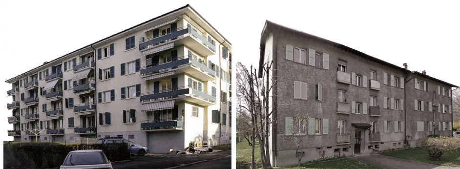
Fig. 25 et 26 de gauche à droite. Bâtiment construit en 1954 à Renens, bâtiment construit à Genève en 1947.
