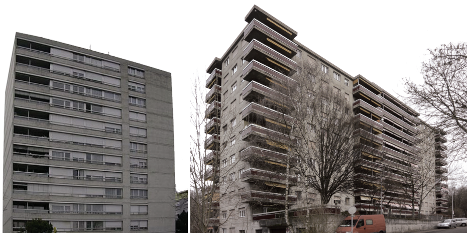
Fig. 33 et 34 de gauche à droite. Bâtiment construit en 1972 à Yverdon, bâtiment construit en 1975 à Fribourg (étude de cas 07).
