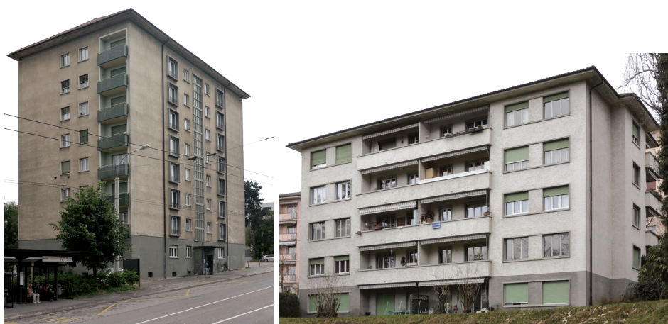
Fig. 29 et 30 de gauche à droite. Bâtiment construit en 1955 à Fribourg, bâtiment construit en 1960 à Lausanne (étude de cas 04).
